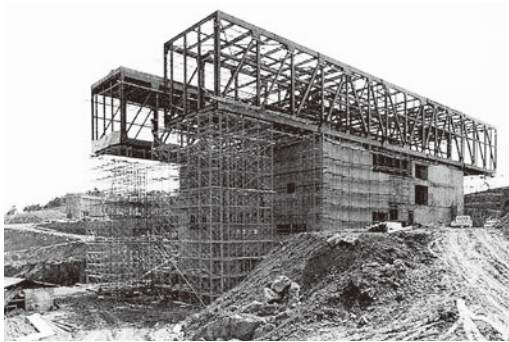
建設中の北九州市立美術館
