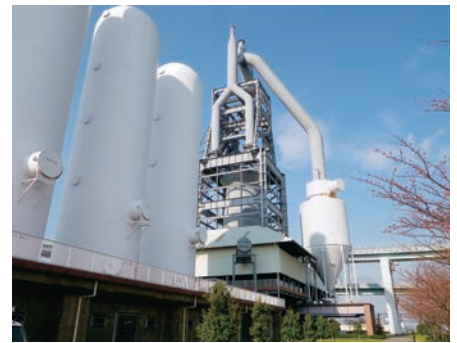
大地の恵みを生かした製鉄産業「東田第一高炉跡」
