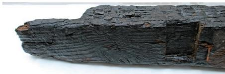
写真2 焼け焦げた天守閣の柱材
