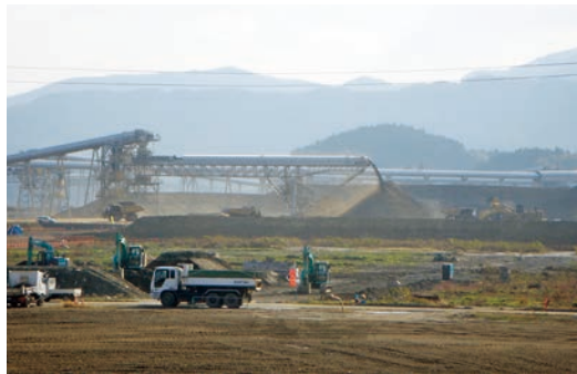
大量の土砂を運ぶベルトコンベアー(2014年11月)
