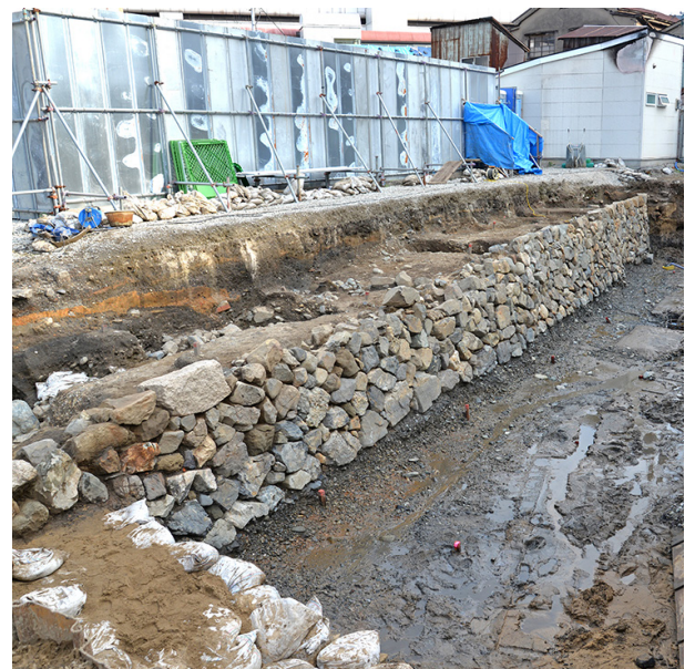
第4図 1区神嶽川護岸石垣 (北西から)
