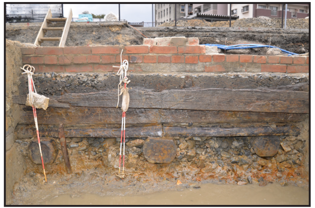
第5図 機関車庫の低地側基礎(桐木組)
