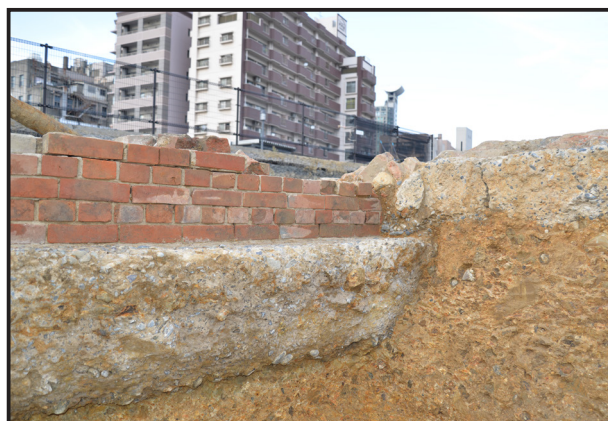
第4図 機関車庫の陸地側基礎（直接コンクリート）
