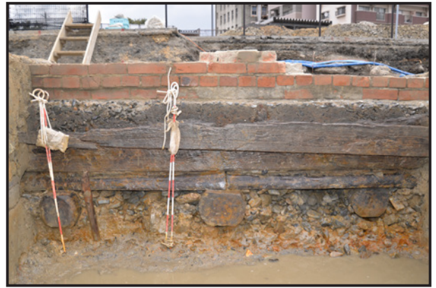
第5図 機関車庫の低地側基礎(胴木組)
