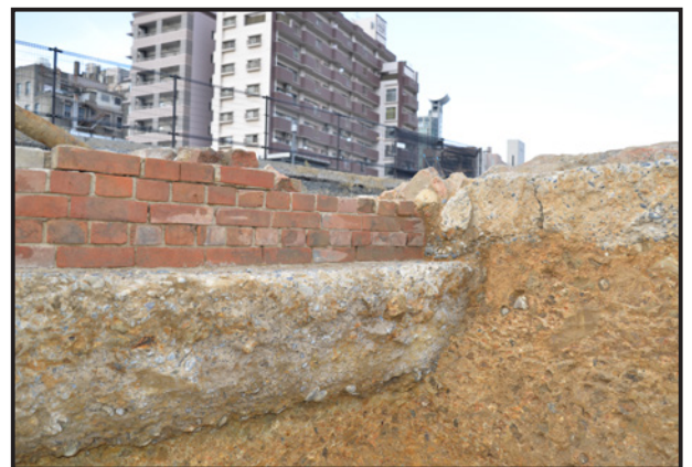
第 4 図 機関車庫の陸地側基礎 (直接コンクリート)
